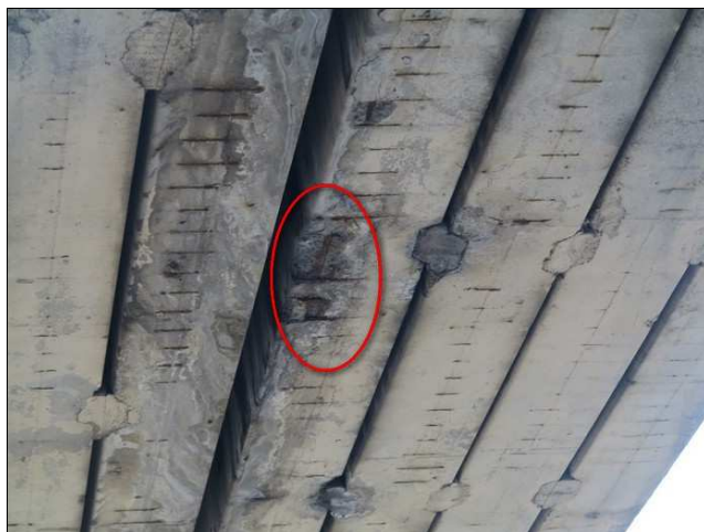
Foto č. 4 – K 02, uražení hrany nosníku až na pravděpodobně předpínací výztuž 5. nosníku.
