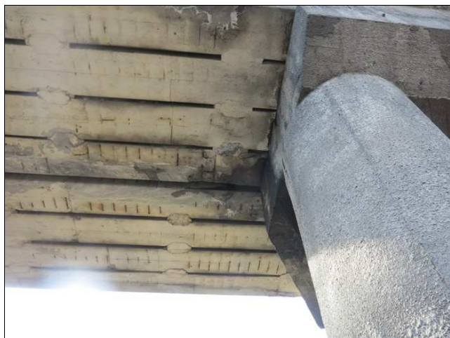
Foto č. 3 – K 02, průsaky mezi nosníky nad P 02
