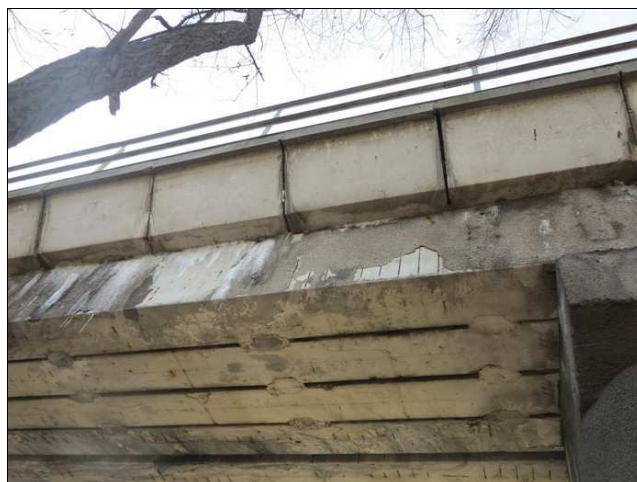
Foto č. 6 – K 03, průsaky s výluhy mezi nosníkem a prefabrikátem římsy vpravo.
