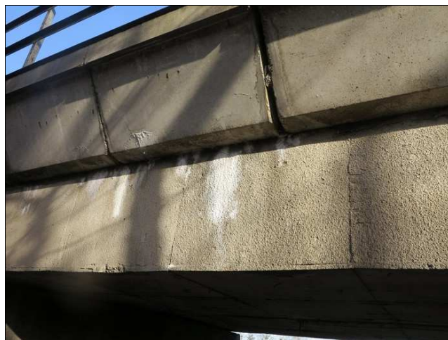
Foto č. 2 – K 01, průsaky s výluhy mezi nosníkem a prefabrikátem římsy vlevo.
