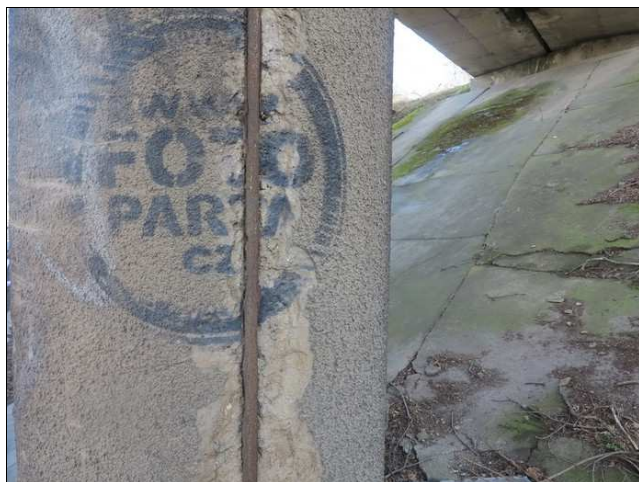
Foto č. 09 – P 01, obnažení a koroze výztuže sloupu č. 1 zleva
