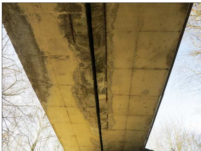
Foto č. 7 – K 04, obnažení ocelové výztuže s korozí
