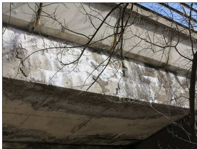
Foto č. 8 – K 04, nepravidelné trhliny s průsaky a výluhy z líce desky vpravo.
