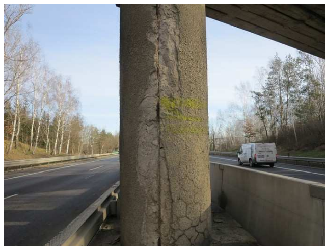
Foto č. 10 – P 02, chybějící výztuž vlevo z líce sloupu č. 1 zleva
